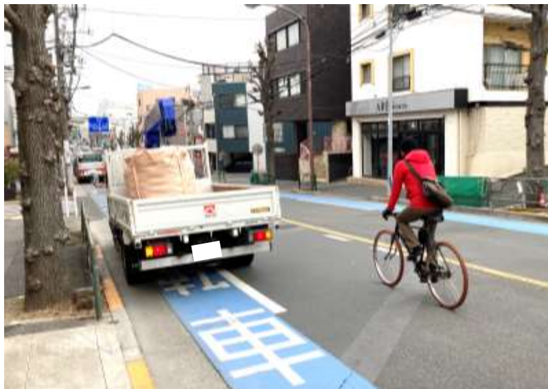
図 2-12 自転車通行空間を塞いでいる駐車車両(世田谷区淡島通り)
