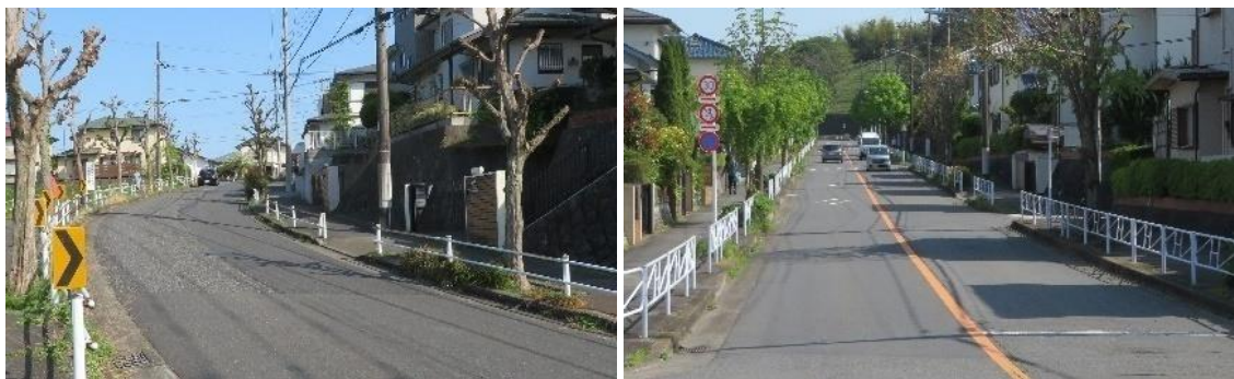
図 2-30 団地内の急な勾配
