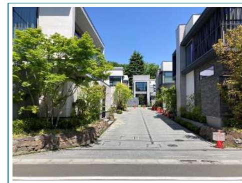
<宅地開発における無電柱化助成事例>
