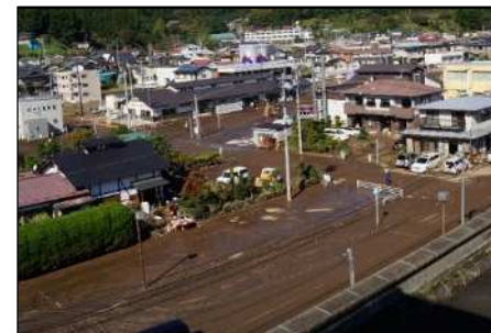
丸森町市街地の土砂堆積状況(12/20)
