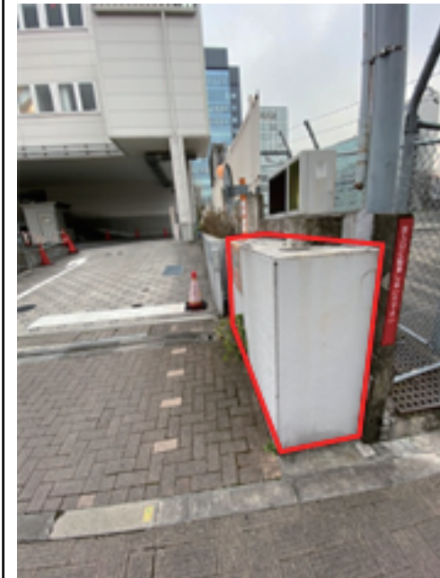
擁壁現況写真
