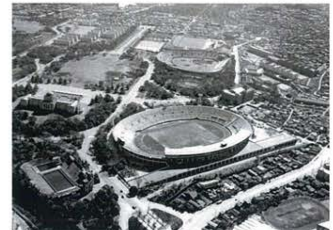
(写真提供：独立行政法人日本スポーツ振興センター／協力：大成建設㈱)
