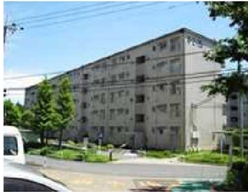
図表 2-32 エレベーターが設置されていない団地例
