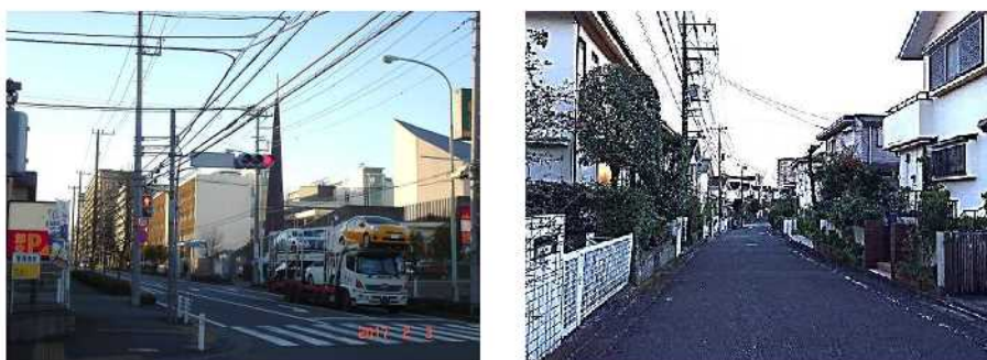
図表 2-16 電柱が林立し電線が輻輳する幹線道路（多摩境通り）・住宅地
