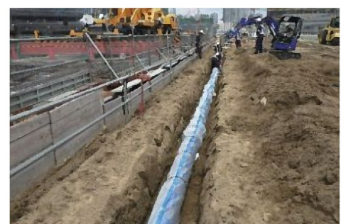
埋設物の設置状況 (平成 30 年 8 月)
