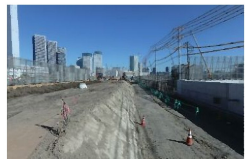
盛土工事の状況 (平成 29 年 11 月)
