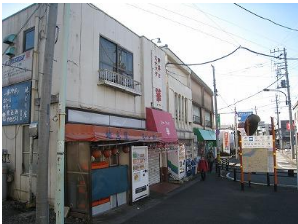
①駅前広場が未整備かつ高度な土地利用がされていない羽村駅西口駅前
