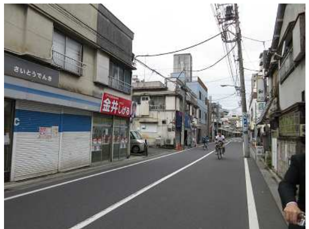
補 285 拡幅予定道路(両側拡幅)を南東より見る(南小岩 4-13 街区)
