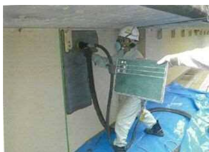
図-5 ブラスト工法作業
