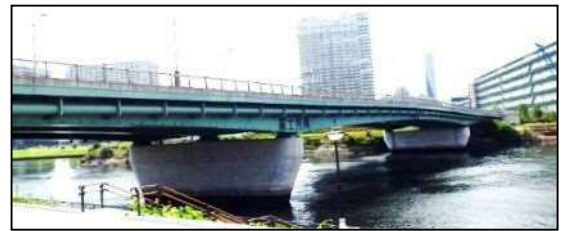
図-1 富士見橋全景
