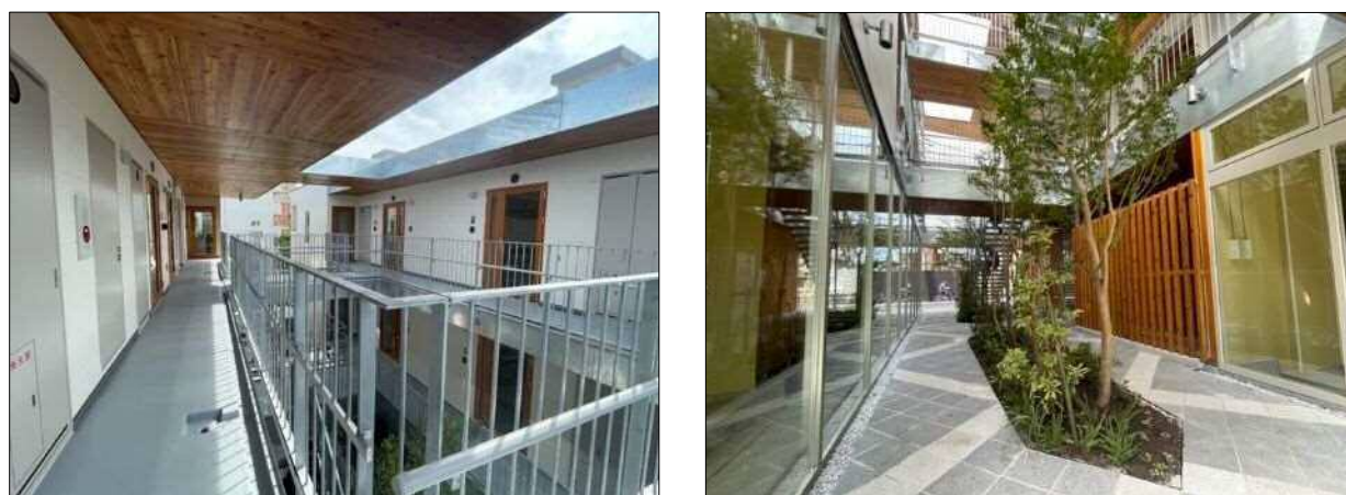
図 13 左写真：3階共用廊下 右写真：通り抜けできる通路「小路」
