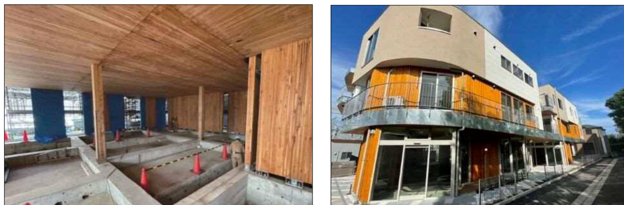
図 12 左写真：1階建方工事中写真 右写真：東(公園)側外観写真
