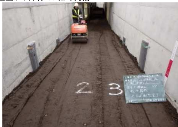
写真7 転圧状況 (振動ローラー)
