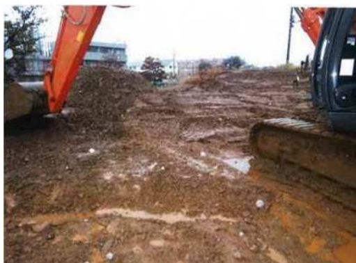
写真5 仮置場の状況写真
