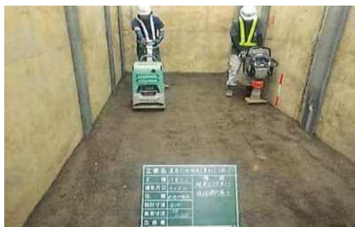
写真8 埋戻し施工状況写真
