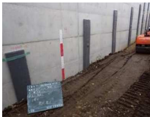
写真6 埋戻し施工状況
