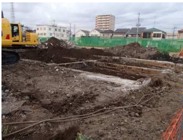
図10 移転完了後の写真(令和4年11月現在)
