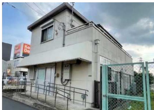
図6 六町地区の店舗併用仮設住宅
