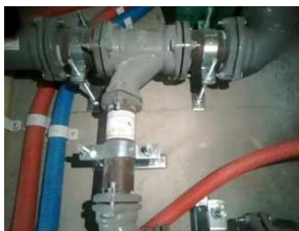
図26 電波を中継した屋内での撮影風景
