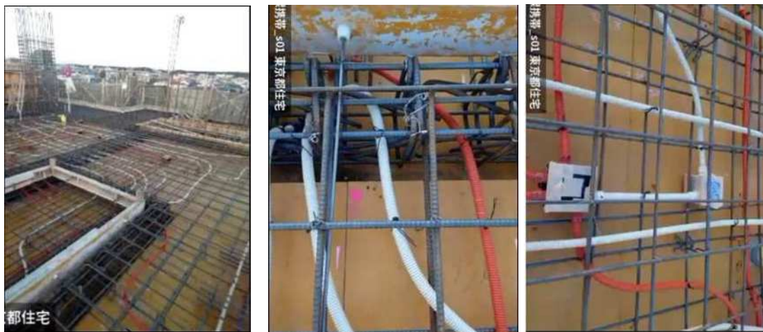
図22 配管検査の配信映像抜粋
