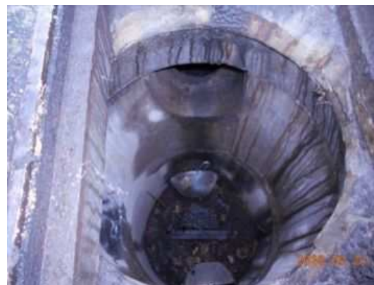
図5 現地踏査した浸透施設
