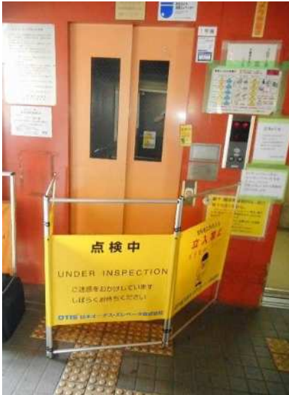
図3 安全柵の設置
