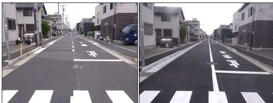
図 8 電線類が地中化された道路（左：工事前、右：工事後）
