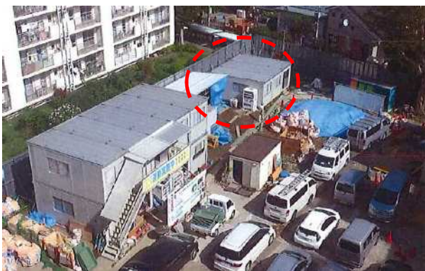
写真5 現場小屋（増設）
