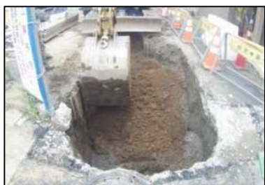
図 7 掘削作業状況映像
