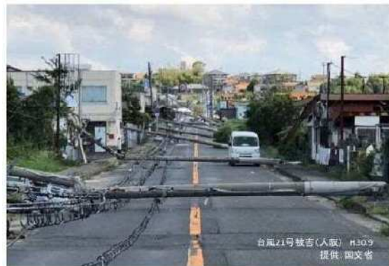
写真1 電線倒壊による被害
