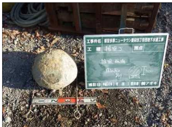
図 14 開削区間で発見された転石
