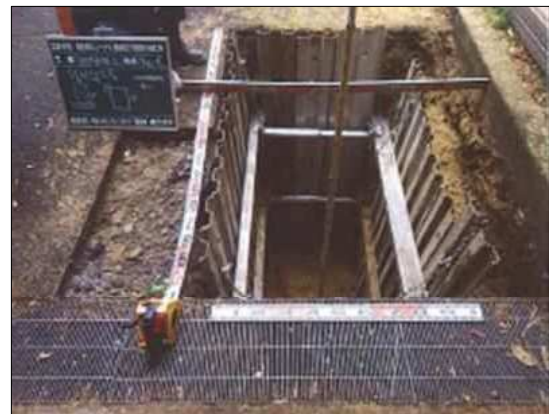
図 12 試掘状況写真
