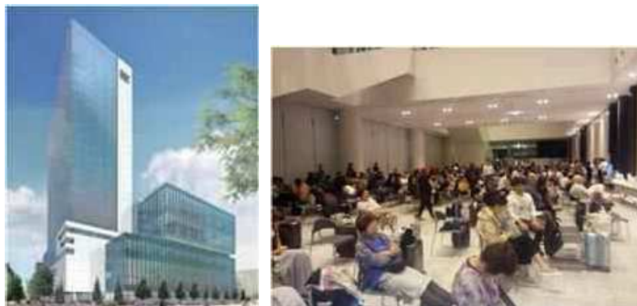
図 6 左) さっぽろ創生スクエア外観、右) 市民交流プラザ (滞留スペース) (※3)
