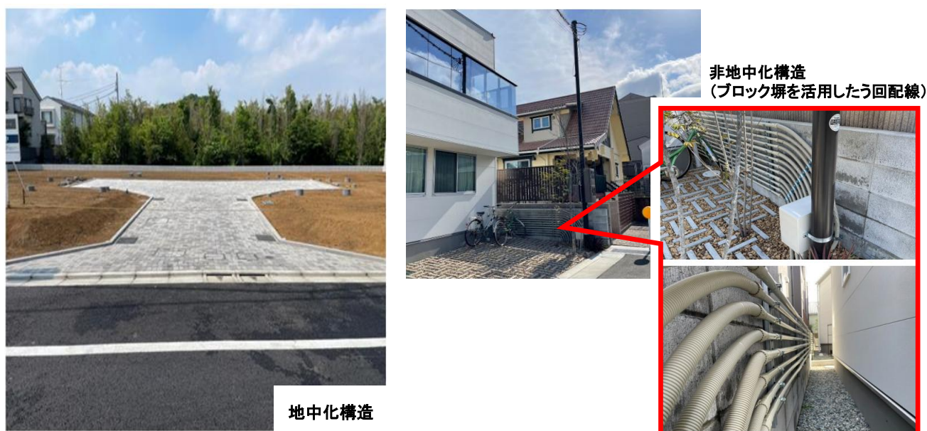
図 - 無電柱化の事例（左：地中化構造、右：非地中化構造）
